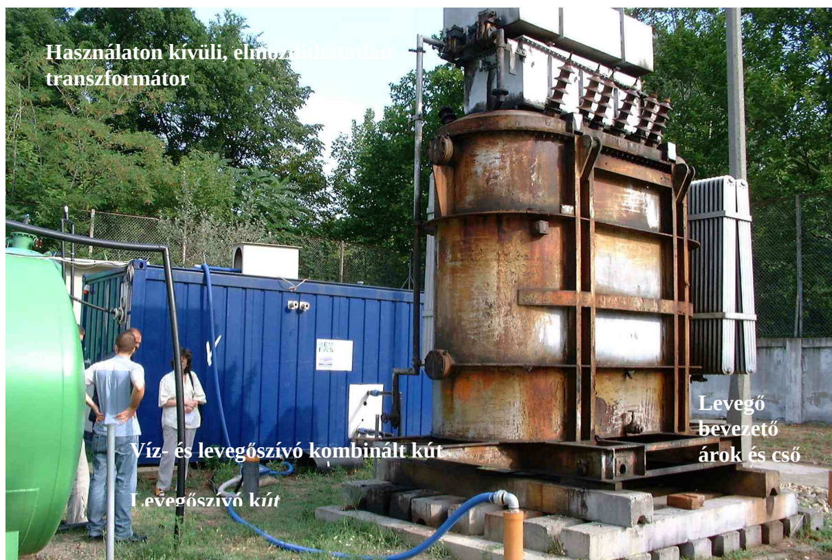
11. ábra: Bioventilláció egy kiselejtezett transzformátor alatti talajtérfogásban
